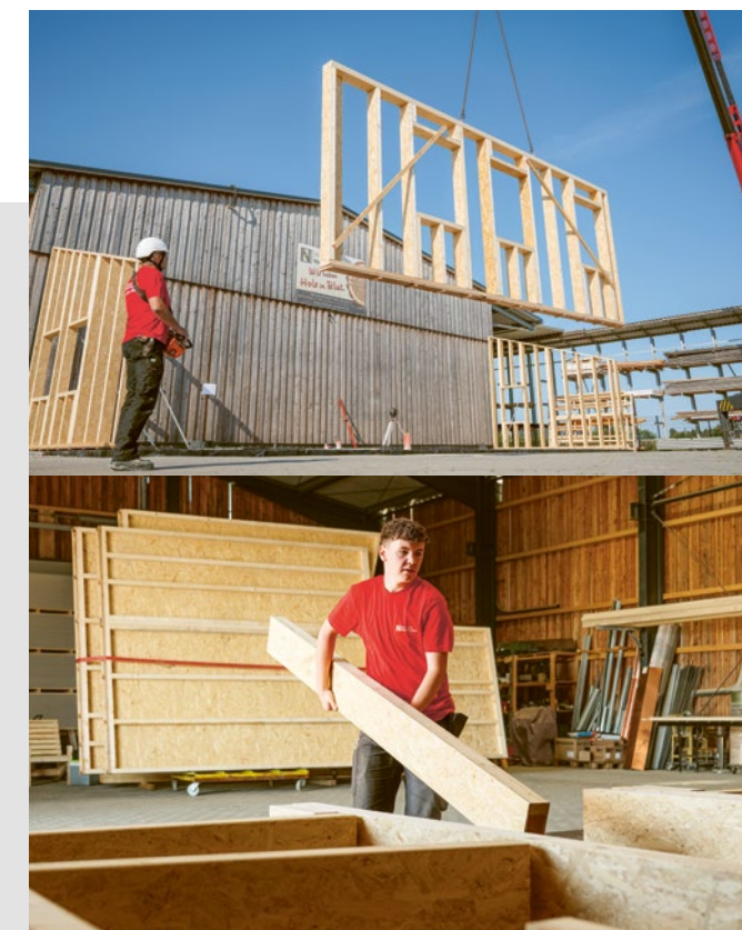
Das Holzbauunternehmen Nortmann baut sich selbst einen Büroanbau mit EcoBox Wandmodulen. Besonders überzeugte dabei ihr geringes Gewicht.
