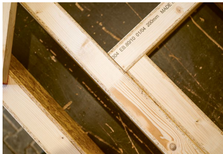
Die EcoBox verleiht auch schlechteren Holzqualitäten eine tragende Rolle. Das verwendete Schnittholz ist keilgezinkt.
