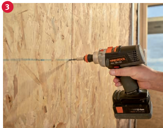
3 Upevněte desku Ergo ve vzdálenosti 150 mm.
