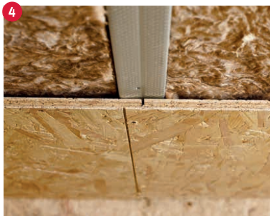
4 Upevněte desku Ergo společně s přiléhající deskou se šroubem ke hrázdné stěně.
