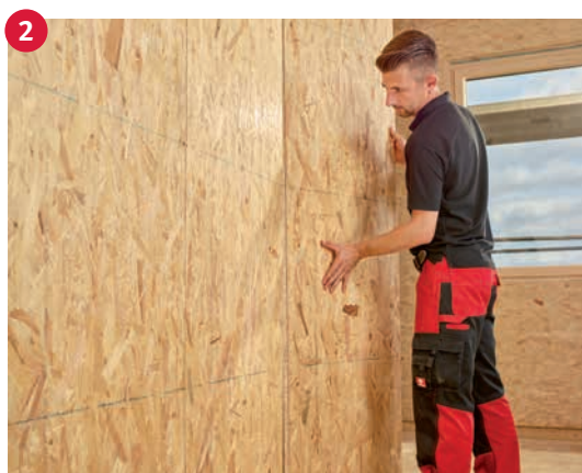
2 Zasuňte do sebe profil se stupňovitou drážkou. Druhá deska bude přidržena v dané poloze.
