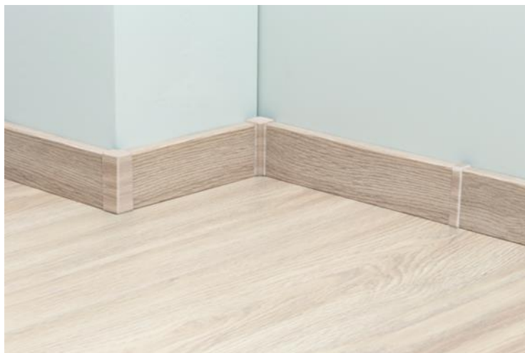
Obrázek 6: Instalace podlahové lišty - Použití EGGER rohových prvků
