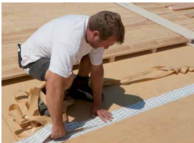
Tudi pri nizkem naklonu strehe DHF plošča zagotavlja varno sekundarno kritino.
